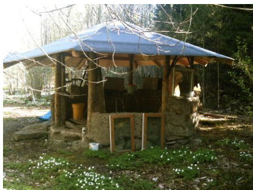
Håller på att byggas
